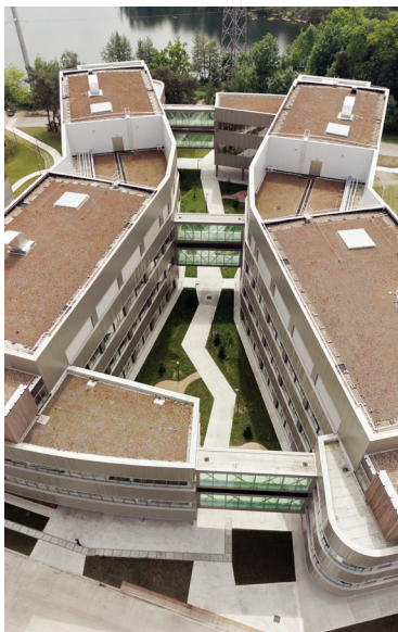
'Niet-parallelle bouwvleugels en transparante bruggen creëren privacy, lichtkwaliteit en een windluwe verbindingsruimte.'
