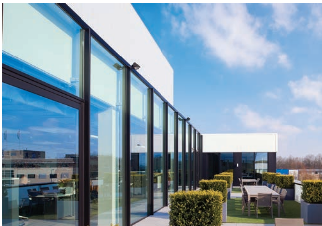
Dakterras aansluitend op designstudio (fase 4)
