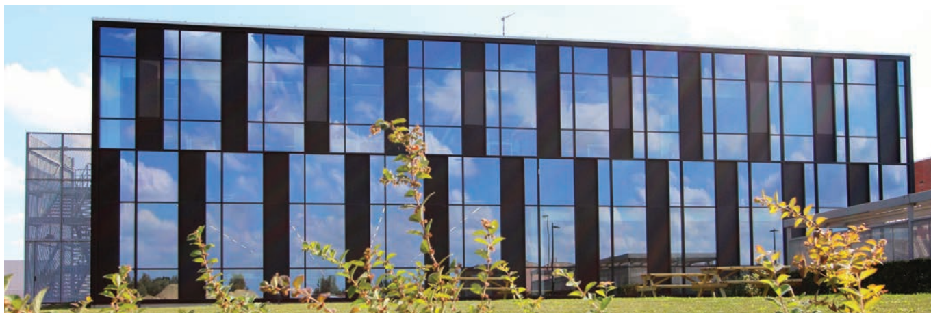
Uitbreiding productieruimte + kantoren (fase 3)
