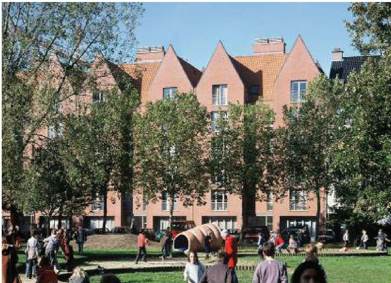
Invalbouw Waalse Kaai –centrum stad
