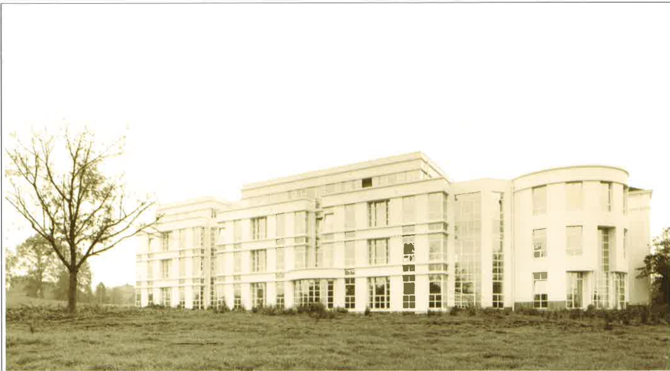
Doorgetrokken horizontale ritmes uit het oude gebouw relativeren het vertikalisme van de opstaande glaspertijen.
