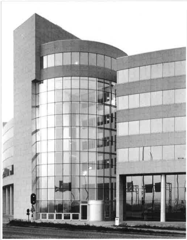
De monumentale gevel in transparant glas onthult de innerlijke ruimte van het atrium.
