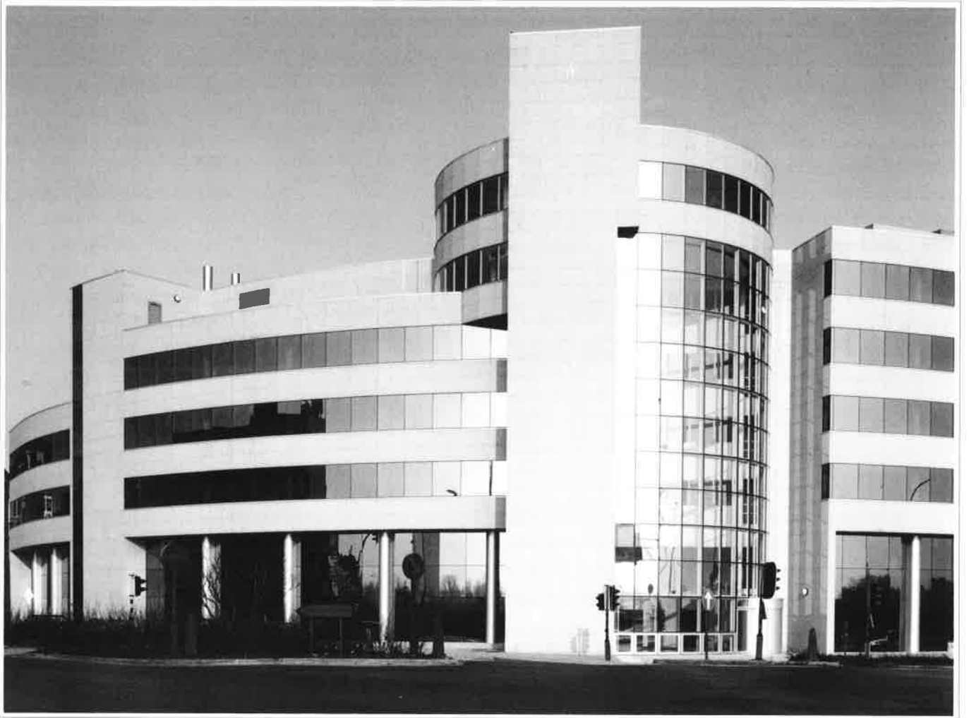
Architect Paul Storme ontwierp een gebouw uit één stuk, dat in een vloeiende beweging de site afrondt waarop het opgetrokken werd.
