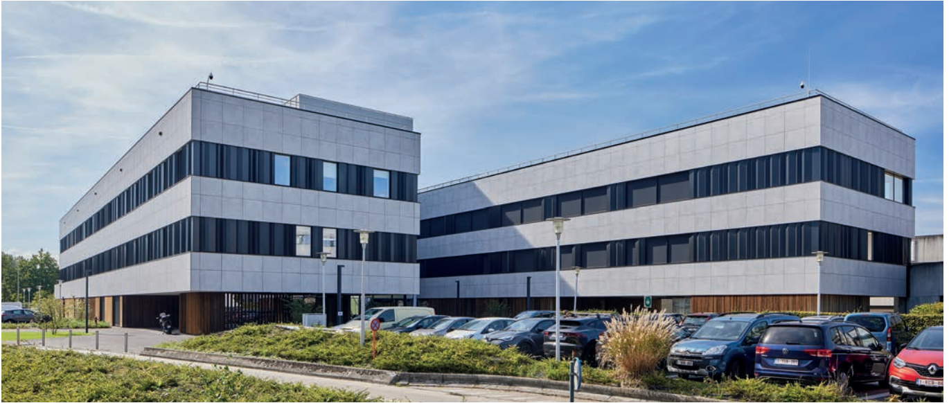
'Twee parallelle, onderling verbonden gebouwen met een horizontaal gevelconcept uit keramische tegels met open voeg en donkere aluminium banden tussen de ramen.'
