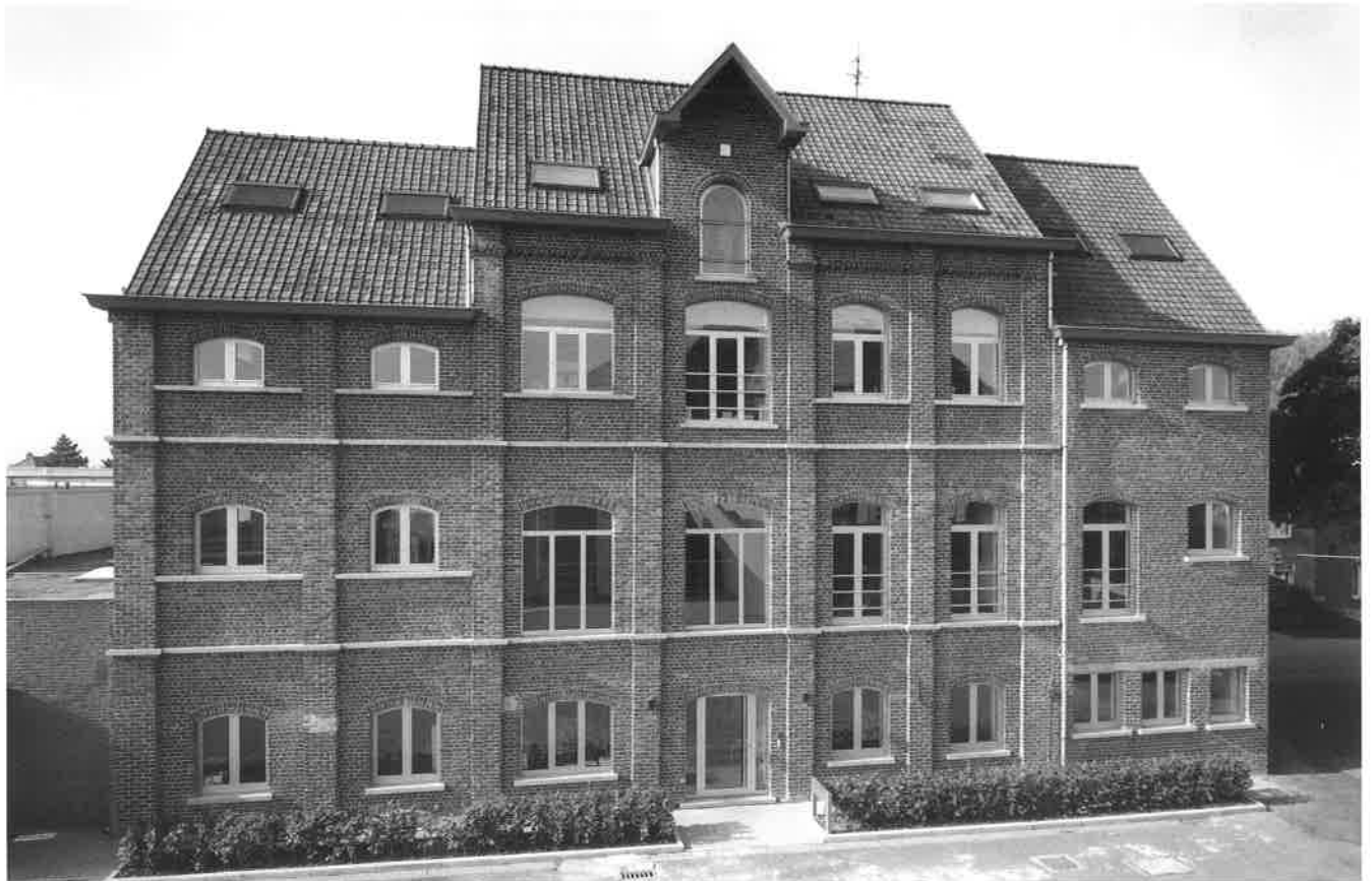
Binnen aangename werkplek, buiten blijvende verwijzing naar het industrieel verleden
