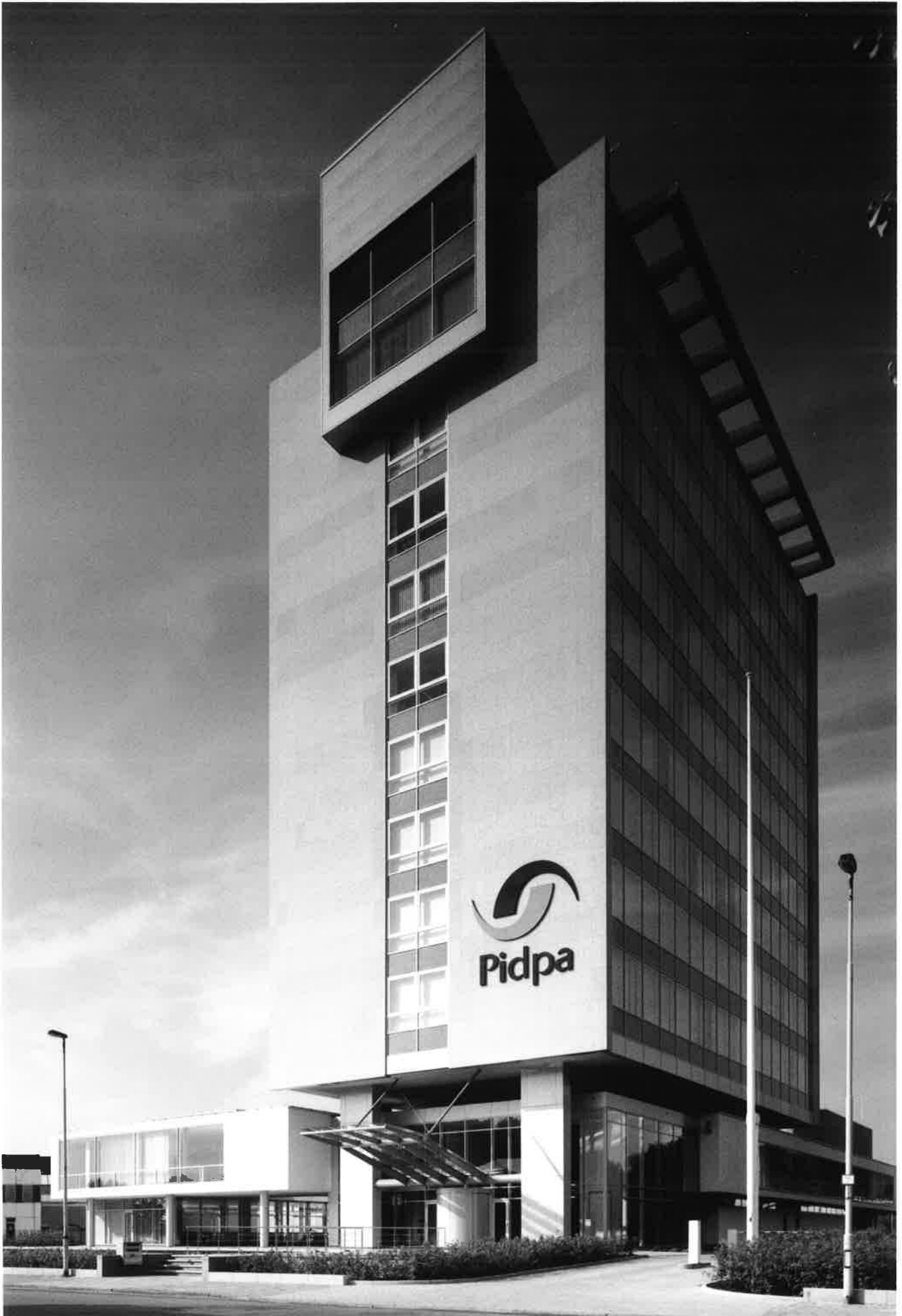
Het nieuwe zenuwcentrum dat duizenden provinciegenoten elke dag opnieuw voorziet van vers drinkwater.
