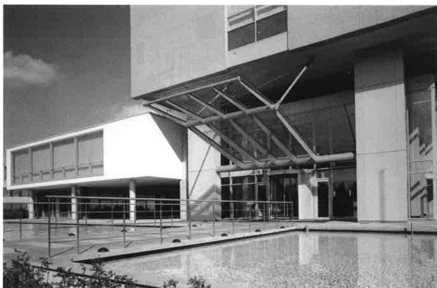
Pidpa, het gebouw heeft onvermijdelijk 'iets met water'.
