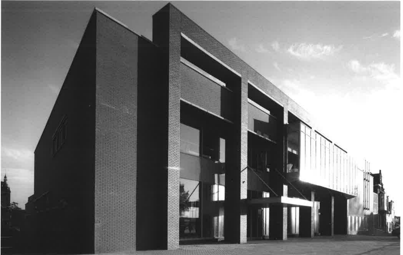
De gevel van het nieuwe Scheldetheater straalt een sobere statigheid uit
