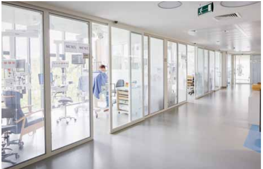
Al even onverwacht zijn de brede, glazen schuifdeuren van de kamers naar de gang.
