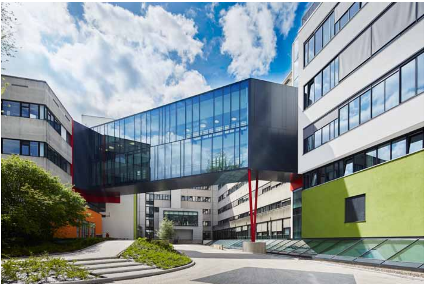
Uitgevoerd in glas, zorgt een monumentale passerelle voor de navelstreng met de andere diensten van het UZA.
