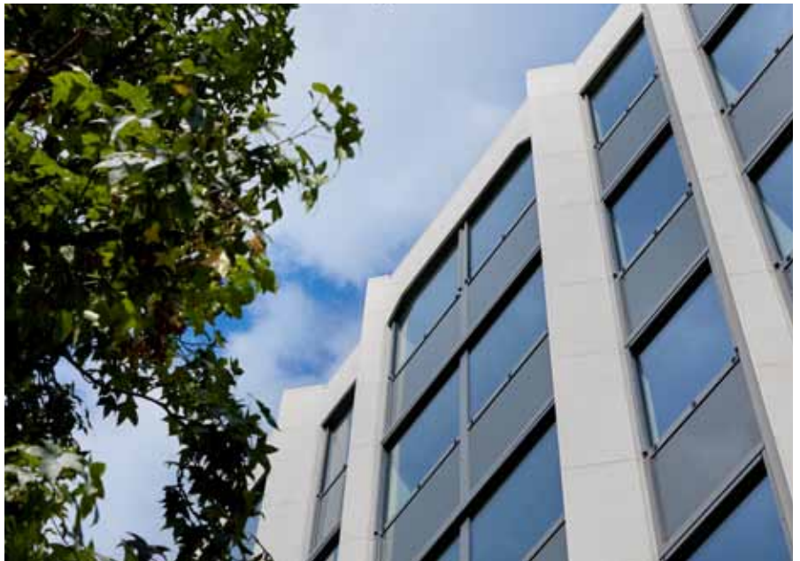
"Lichtkleurige aluminium ramen, voorzien van zonwering in dezelfde kleur, maken de gevel minder druk."
