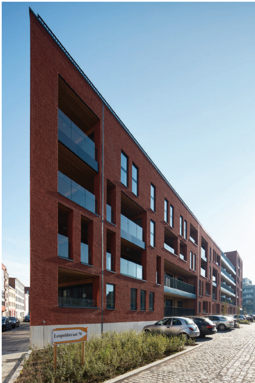
"De bovenzijde van de inpandige terrassen is overal met thermowood bekleed."
