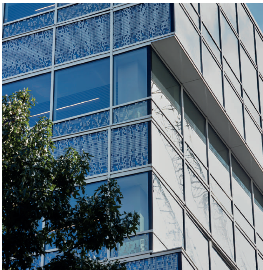
'Heldere glasvlakken, deels bekleed met seriegrafie of opake elementen maken het gebouw meer en minder doorzichtig.'
