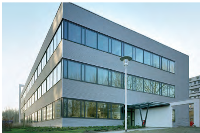
Administratief gebouw (foto 1/2)
