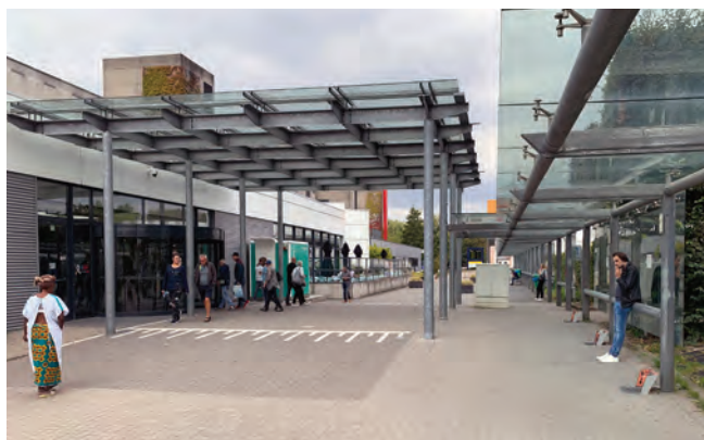
Nieuwe infrastructuur (foto 2/4)
