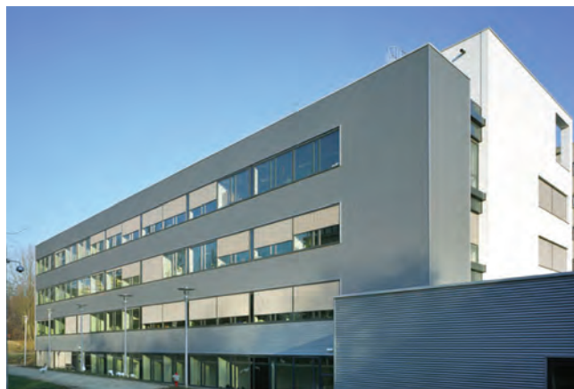
Administratief gebouw (foto 2/2)
