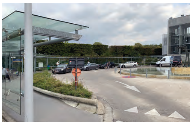
Nieuwe infrastructuur (foto 1/4)
