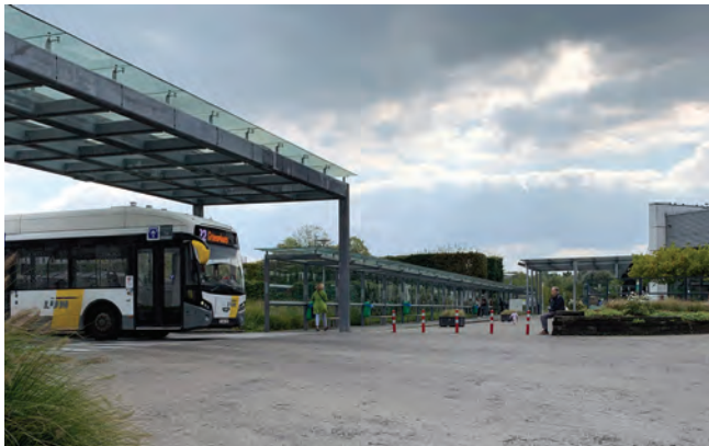
Nieuwe infrastructuur (foto 4/4)
