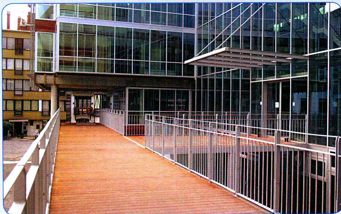
Binnenkomen kan via de stalen passerelle of via de het verlaagde voorplein.
