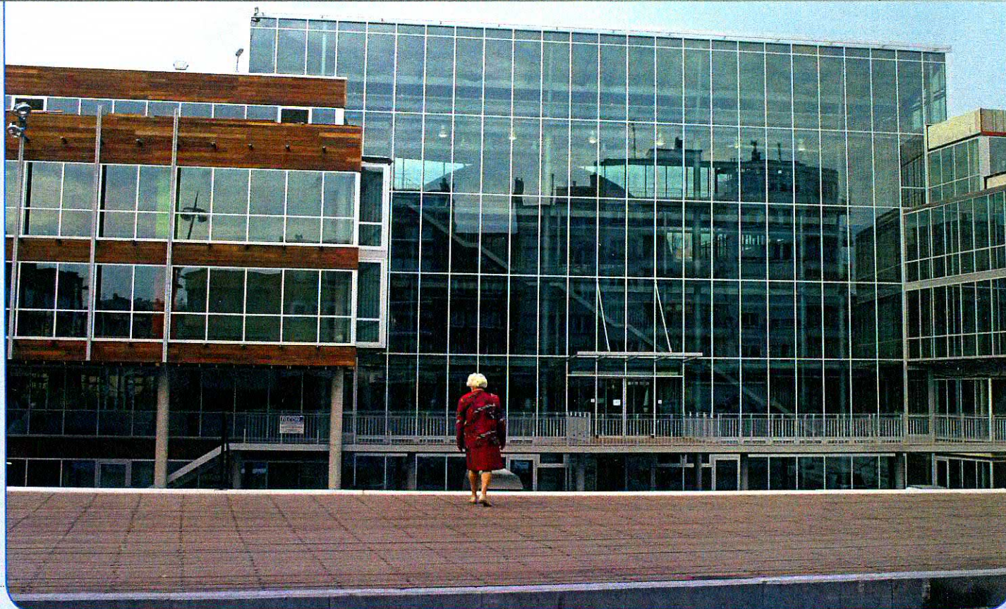
Het gemeentehuis omvat twee identieke kantoorvleugels met cederhouten buitenbekleding en tussenin een indrukwekkend atrium met de ellipsoïde
