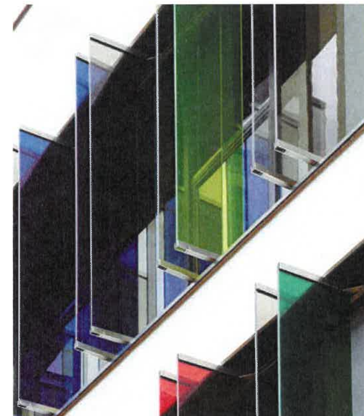
Zonwerende lamellen zorgen voor een gevarieerd kleurenpalet. De bepleistering van de rest van de gevel draagt bij aan de luchtdichtheid. (FT/SVR)
