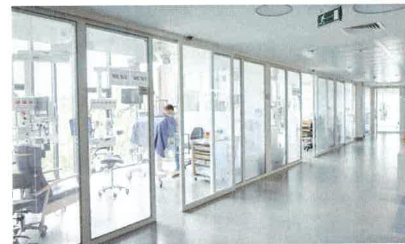
Al even onverwacht zijn de brede, glazen schuifdeuren van de kamers naar de gang. (SM/SVR)
