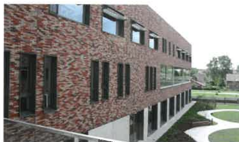
Het oude gebouw uit het begin van de jaren zeventig wordt na de zomer van 2017 gesloopt.
