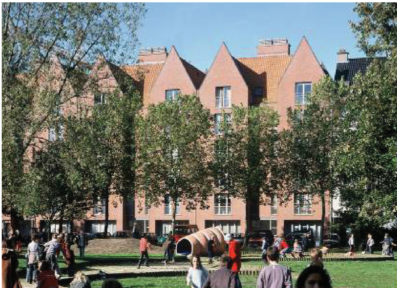
Invulbouw Waalse Kaai –centrum stad
